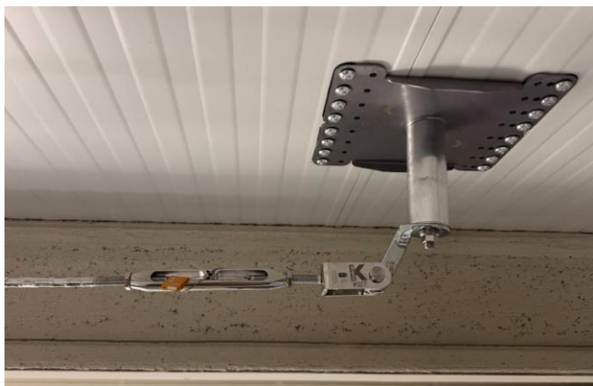
Detalle del sistema instalado con testigo de tensión aplicada
