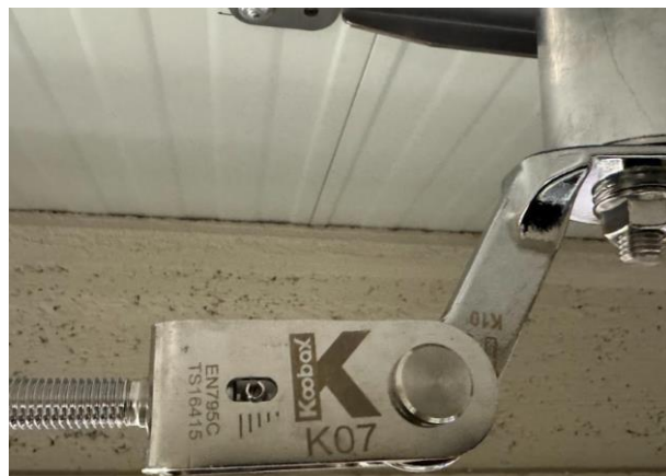
Detalle del sistema instalado con testigo de tensión aplicada
